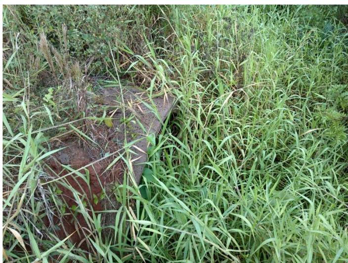
Figura 31 – Obstrução da saída das canalizações de drenagem.
