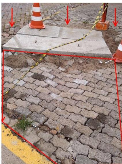
Figura 48 – Caixa de inspeção da rede pluvial danificada.
