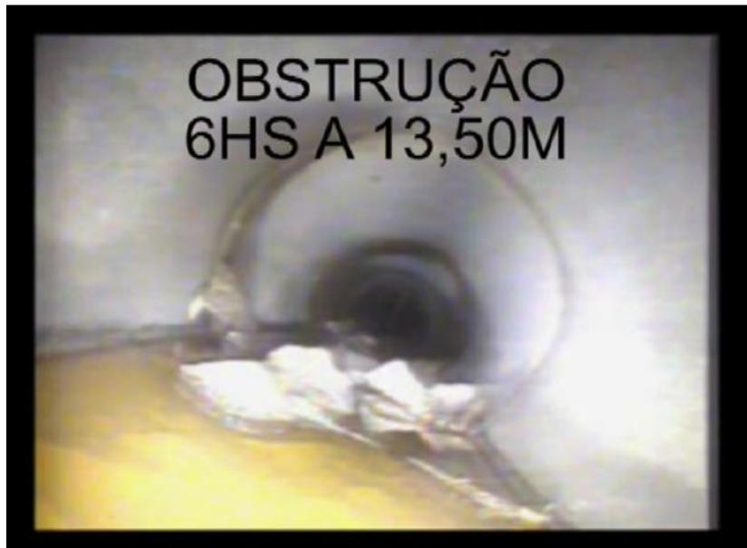
Figura 64 – Exemplo das imagens obtidas por um sistema de televisionamento de redes pluviais.
