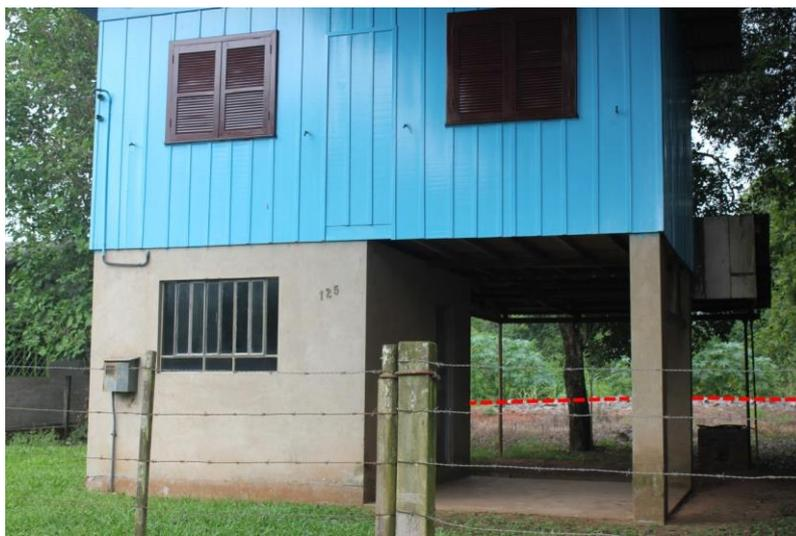
Figura 18 – Residências adaptadas a condição de inundação ocupando área de preservação permanente do rio Pardinho.
