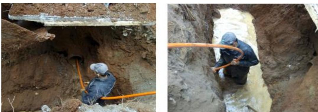
Figura 12 – Manutenções executadas nas redes para o desentupimento.
